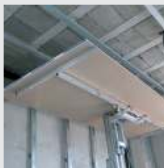
Montaje de paneles de pladur.
