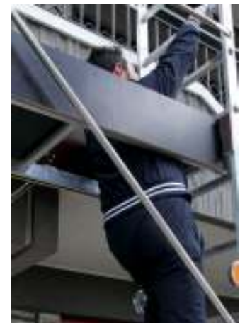
Plano de trabajo con trampilla para acceder en seguridad desde el interior.
